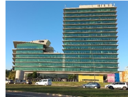
Nordlink (Rosario, Argentina) 9 elevators
